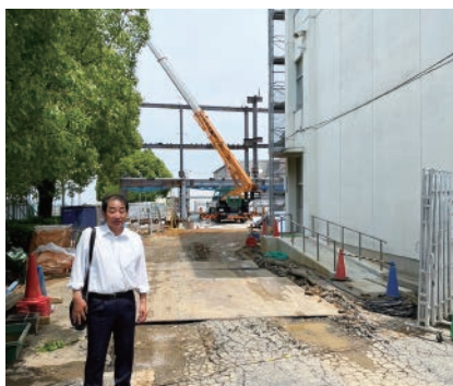
明石商業高校 福祉科の工事現場を訪問
